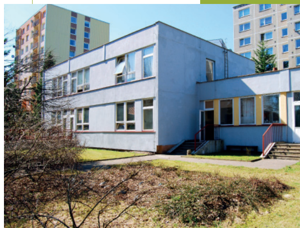
Budova sídla Fokusu v Nezvalově ulici
